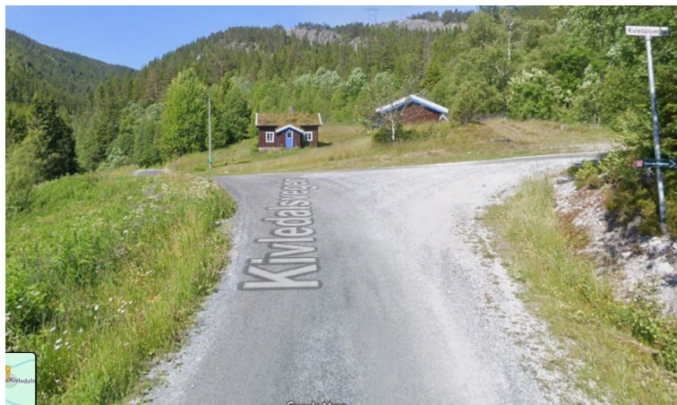
Figur 3: Sett fra Kivledalsvegen, brua til venstre
